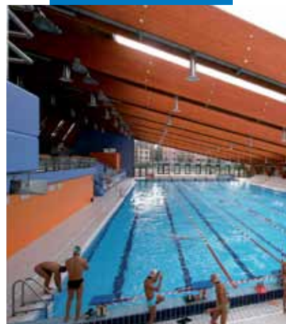
Piscina impermeabilizada con Mapelastic - Piscina Scarioni (Milán) Italia
