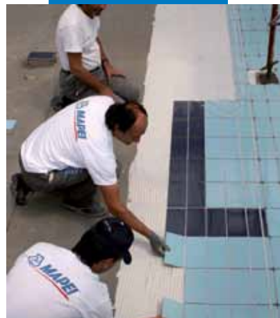
Colocación de revestimiento cerámico sobre Mapelastic
